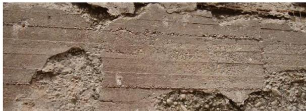
*Figura 4. Erosión del concreto.*
