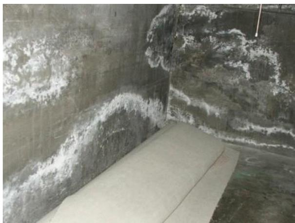
**Figura 7. Eflorescencia en el concreto.**
