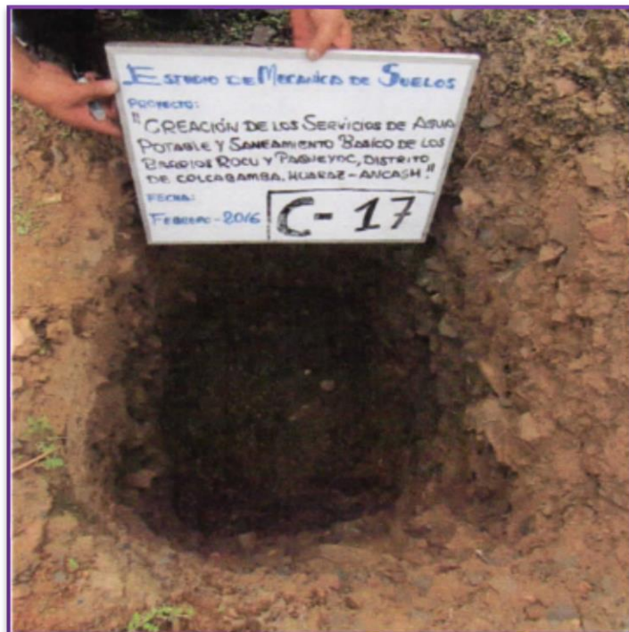
Fotografía 08: Se puede apreciar la exploración de calicata a cielo abierto en la proyección de la red de distribución.
