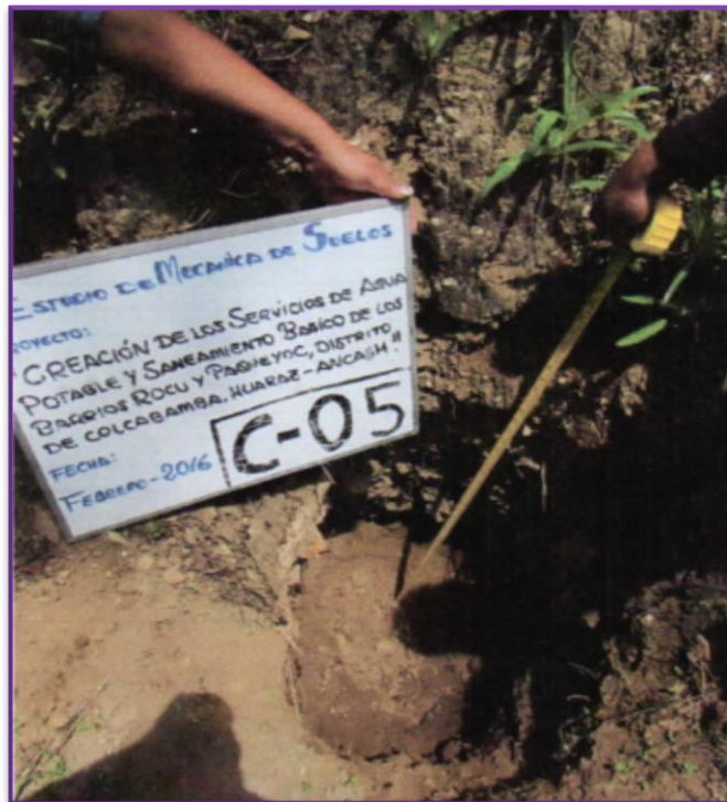
Fotografía 06: Se puede apreciar la exploración de calicata a cielo abierto en la línea de conducción.
