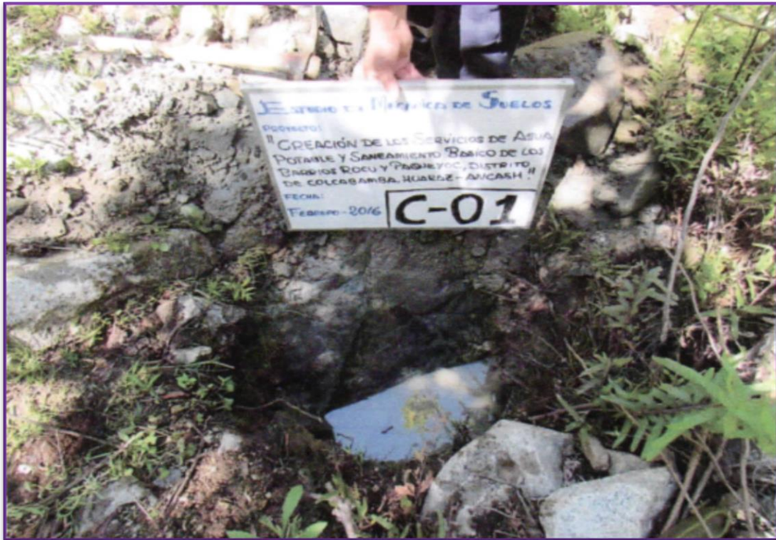
Fotografía 05: Se puede apreciar la exploración de calicata a cielo abierto en la captación.
