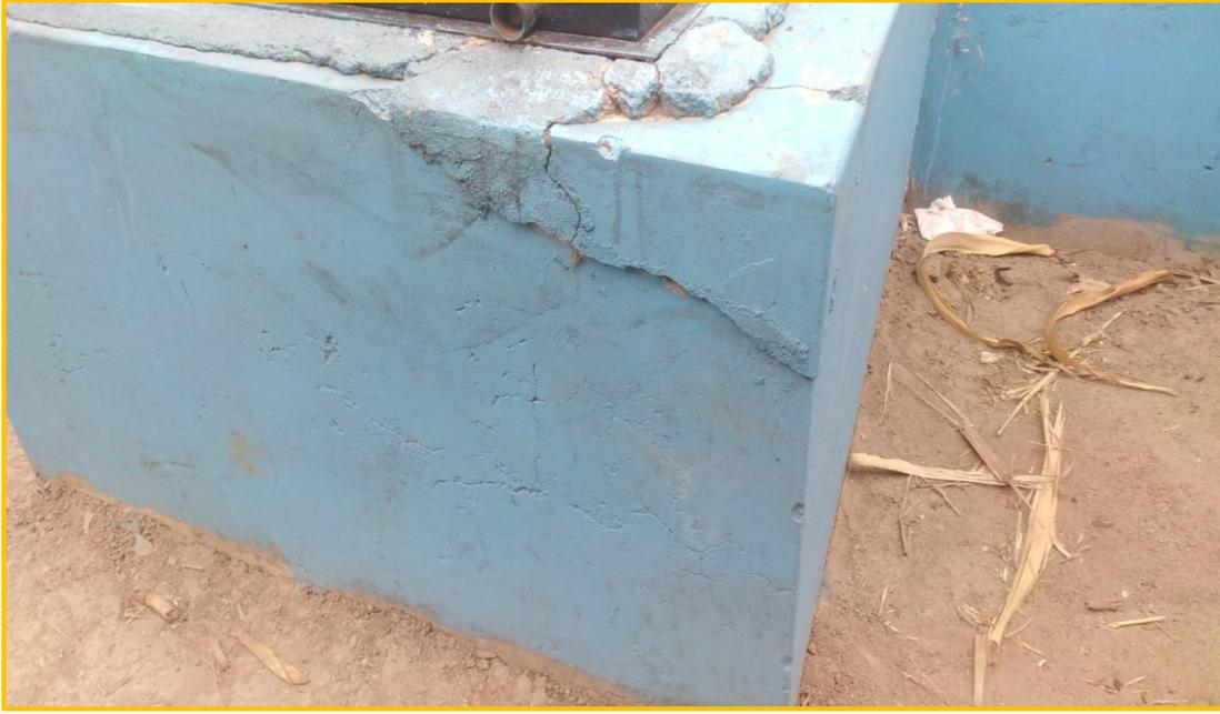
**Fotografía 07:** Desprendimiento en la parte superior de la caja de válvulas del reservorio.
