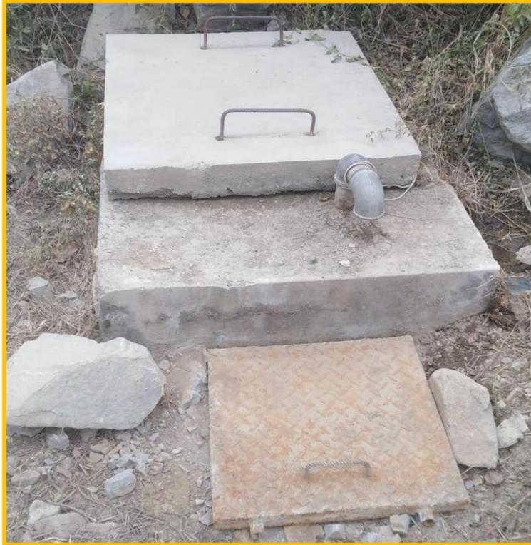
**Fotografía 19:** Caja de válvulas de CRP-6 se aprecia con deterioro tanto en el concreto como en la tapa metálica.
