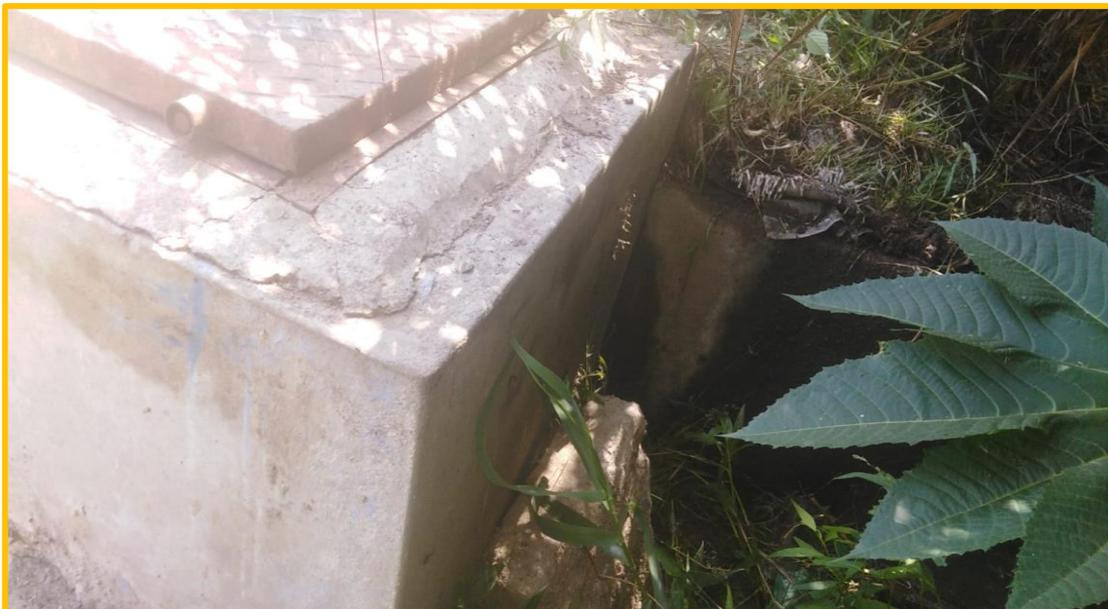
**Fotografía 04:** Se aprecia en la parte del filtro de la captación lleno de maleza.
