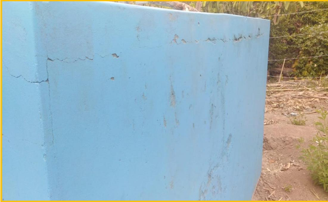
**Fotografía 05:** Reservorio con problemas de fisuras y grietas en su estructura.
