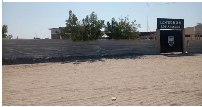
Cuadro 7: Calles sin capa de rodadura
