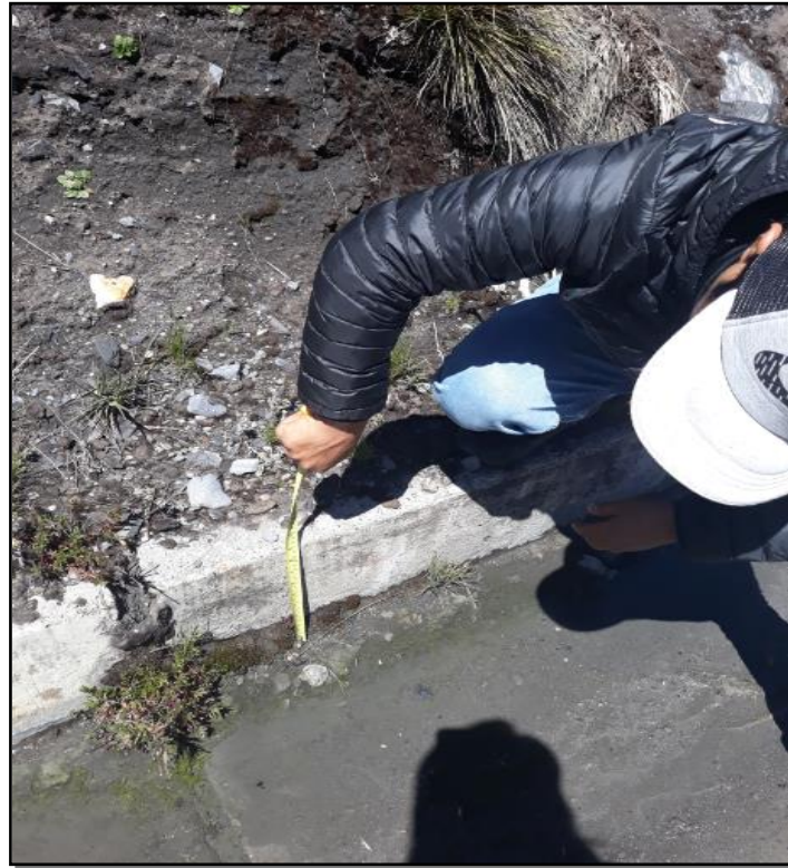
Fotografía N° 03: vista de la toma de medida en el margen izquierdo de la cuneta.
