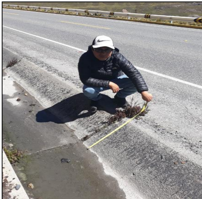
Fotografía N° 04: vista de la toma de medida en el margen derecho de la cuneta.
