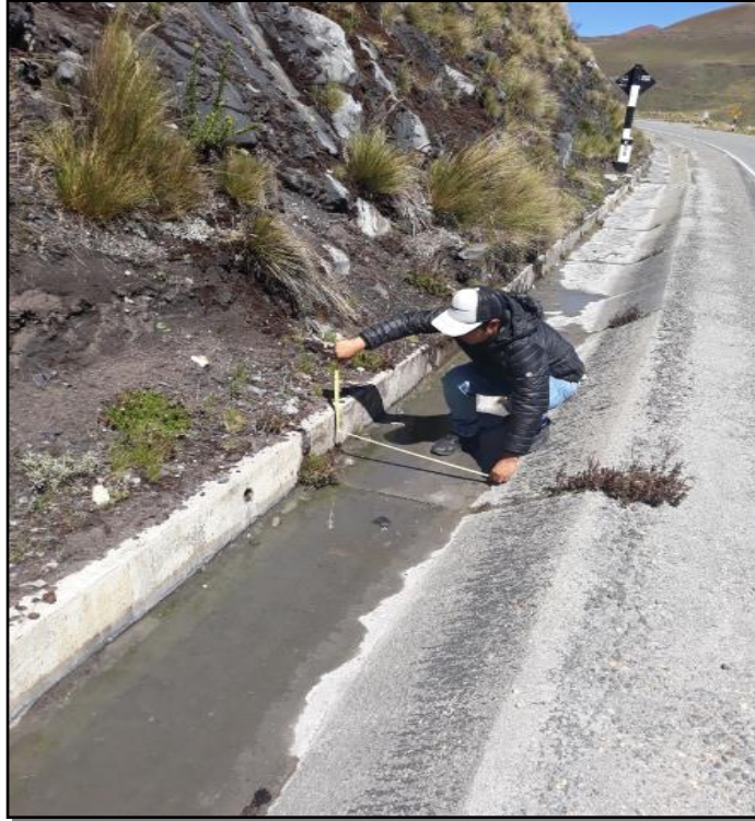
Fotografía N° 01: vista de la toma de medida en el piso de la cuneta.
