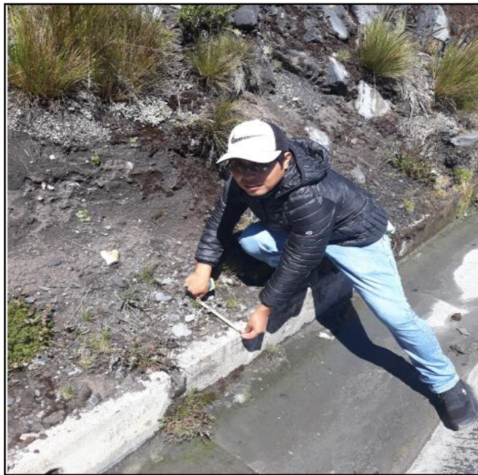
Fotografía N° 02: vista de la toma de medida del espesor de la cuneta.
