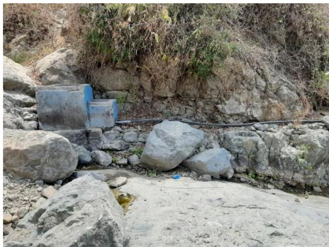
Observaciones: la línea de conducción se encuentra funcionando, pero tiene deficiencias en el transcurso del recorrido de la línea, ya que no cuenta con cámaras rompe presiones, válvulas de aire, de purga y de control, además le sumamos a esto que las tuberías se encuentran expuestas
