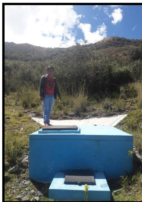
Imagen 03: Captación 3 Fuente: Elaboración propio.
