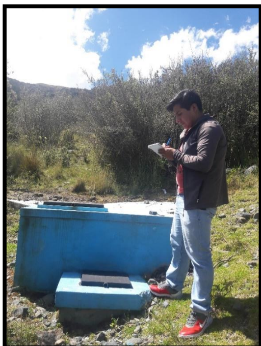
Imagen 02: Captación 2 Fuente: Elaboración propio.
