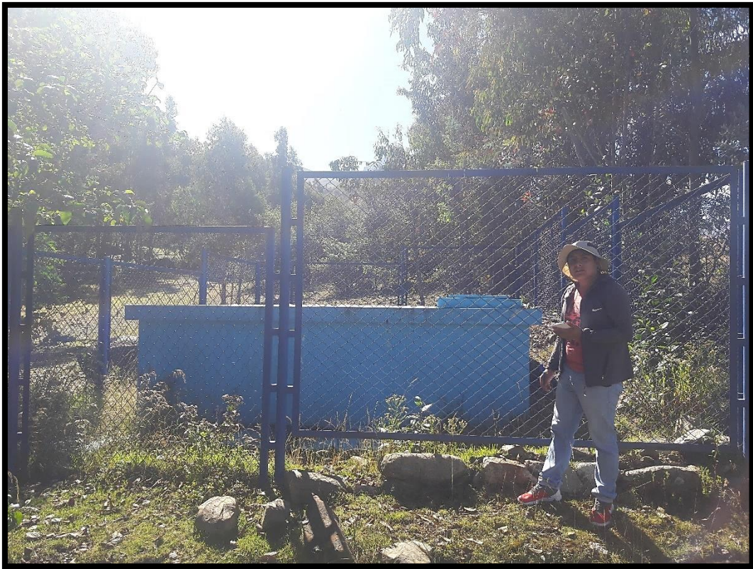
Imagen 04: Reservorio. Fuente: Elaboración propio.
