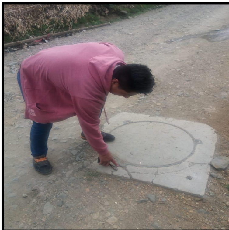
Imagen 09: Buzón de la red de desagüe. Fuente: Elaboración propio.
