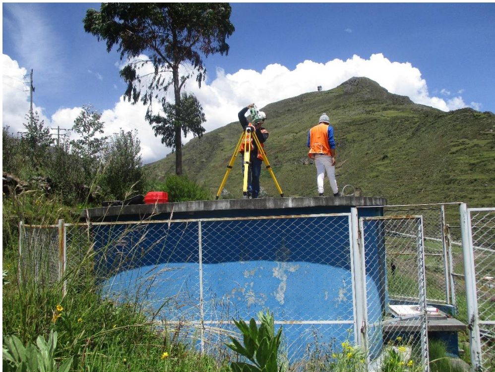
FOTOGRAFIA N°03: Realizando los trabajos de levantamiento topográfico (cambio de estación)
