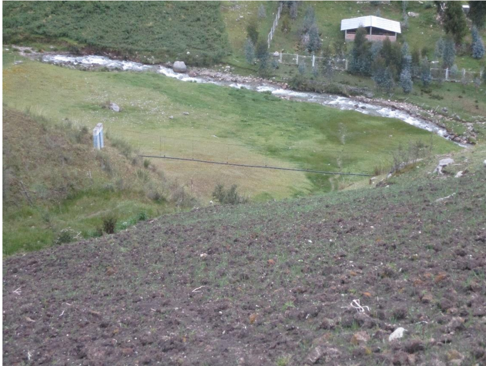
Fotografía N° 05: Cruce aéreo existente.
