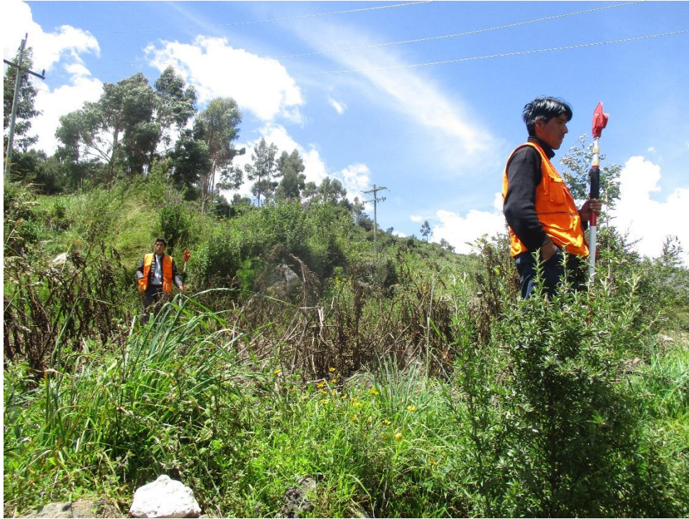
FOTOGRAFIA N°02: Realizando los trabajos de Levantamiento topográfico de PICHU CENTRO.
