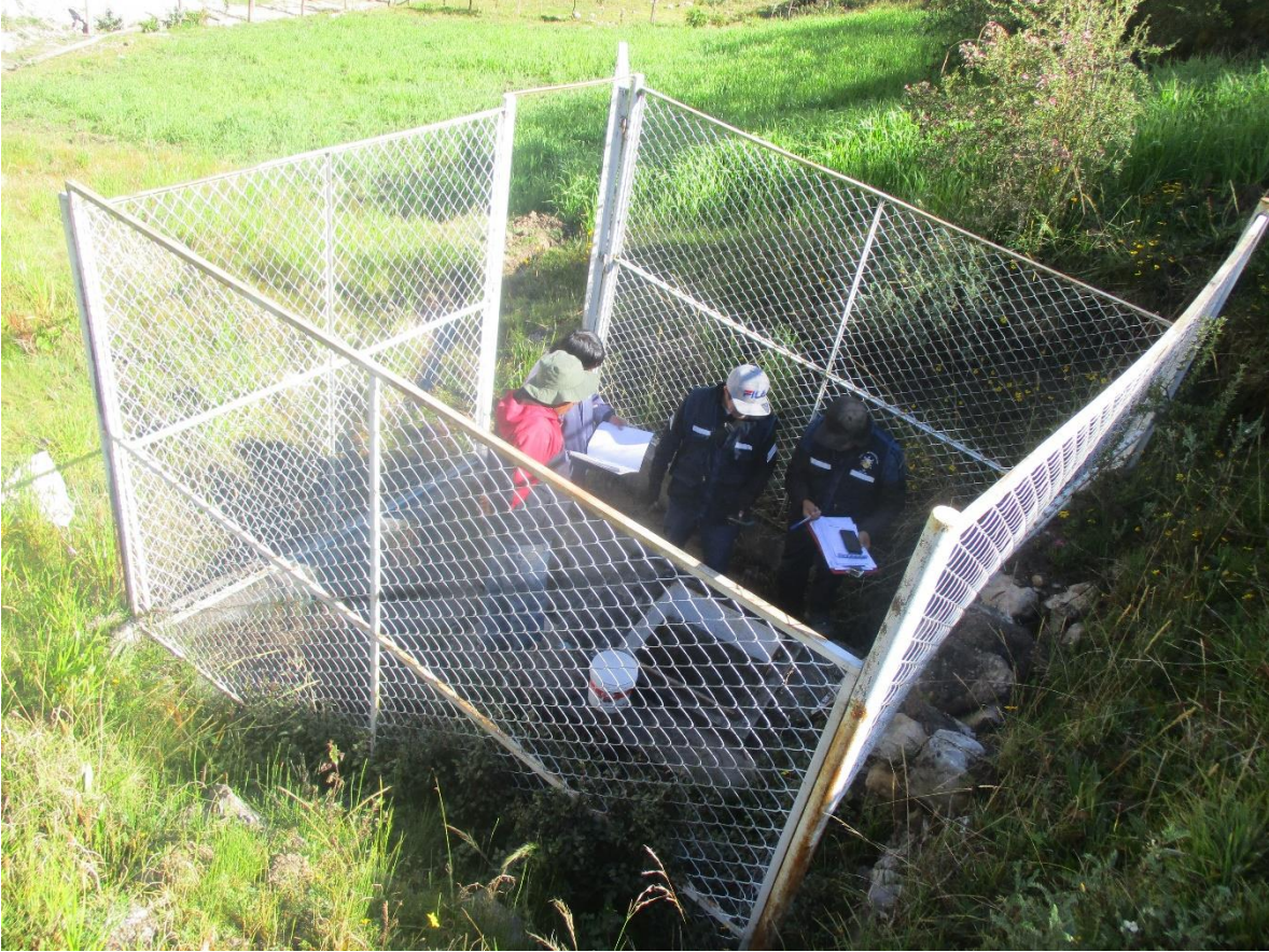
Imagen 1. Captación de ladera Monerpuquio de la localidad de Pichiu Centro
