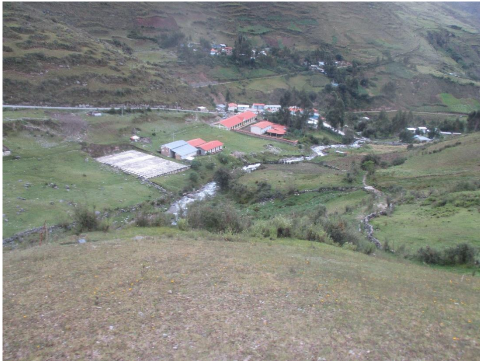
Fotografía N° 01: Vista panorámica de viviendas de la Localidad de PICHU CENTRO.
