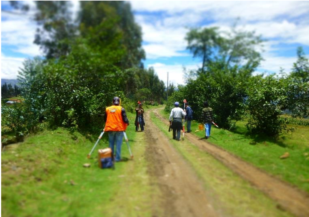
Imagen 3. Levantamiento topográfico en zona del tramo de la línea de conducción
