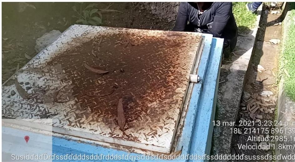
Fotografía: Tapa metálica oxidada – CRP-T6
