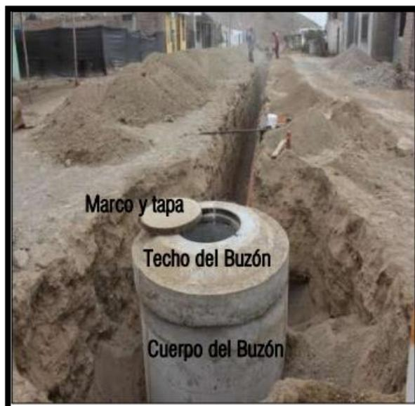
Figura 23. Sistema de alcantarillado sanitario
