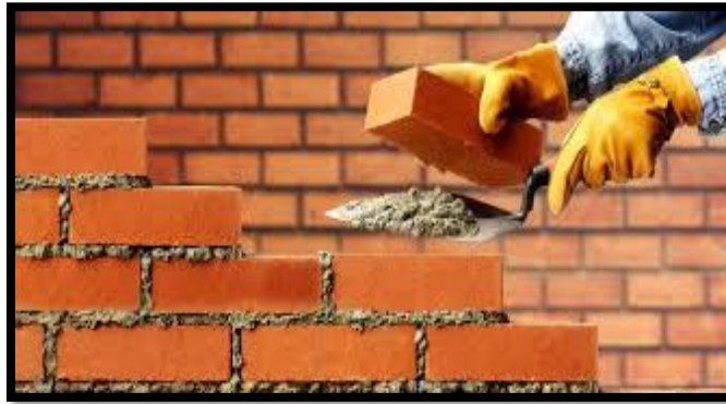
Figura 04: Unidad De Albañilería Sólida o Maciza .
