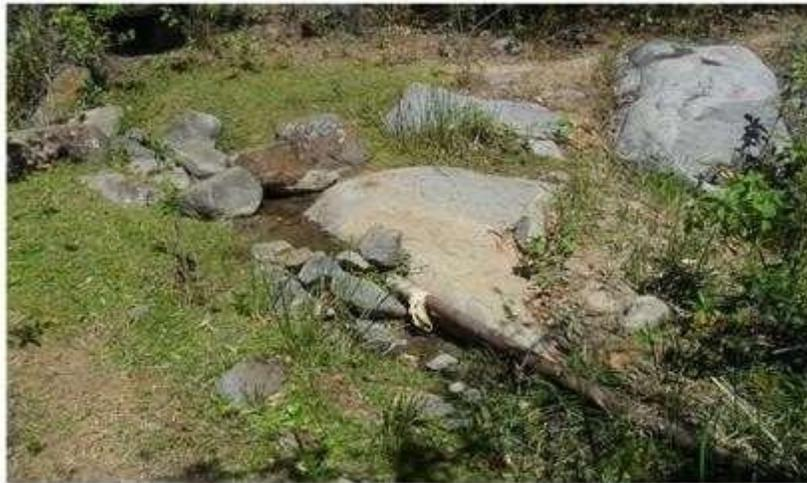
**ILUSTRACIÓN 6 CAPTACIÓN DEFICIENTE - REBASAMIENTO DE AGUA POR DETERIORO DE CÁMARA DE CAPTACIÓN Y FILTRADO**
