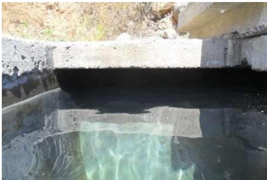
**ILUSTRACIÓN 8** CAPTACIÓN QUE CARECE DE CERCO Y EL VOLUMEN DE AGUA REBASA POR LOS COSTADOS PUESTO QUE PRESENTA GRIETAS, QUE POR LA CARENCIA DE CERCO LOS ANIMALES QUE PASTEAN POR LA ZONA LO DETERIORAN
