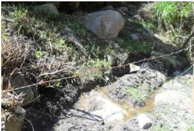
**ILUSTRACIÓN 7** CAPTACIÓN QUE CARECE DE CERCO Y EL VOLUMEN DE AGUA REBASA POR LOS COSTADOS PUESTO QUE PRESENTA GRIETAS, QUE POR LA CARENCIA DE CERCO LOS ANIMALES QUE PASTEAN POR LA ZONA LO DETERIORAN
