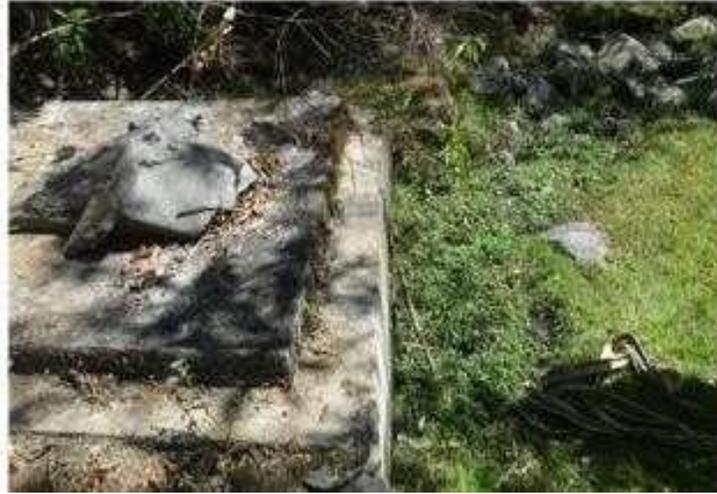
**ILUSTRACIÓN 2. CÁMARA DE FILTRO DE AGUA, NO CUMPLE FUNCIÓN POR LA CARENCIA DE LIMPIEZA Y MANTENIMIENTO EN ESTA INFRAESTRUCTURA.**
