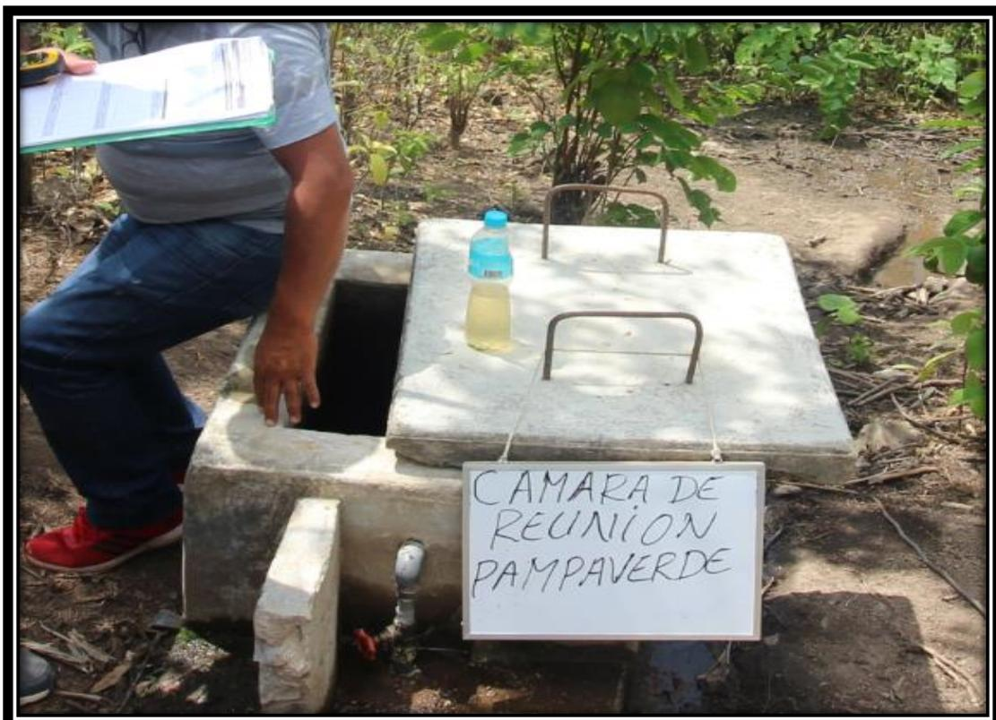
*Fotografía 22:* **Cámara de reuniones existente enterrada y deteriorada en mal estado.**
