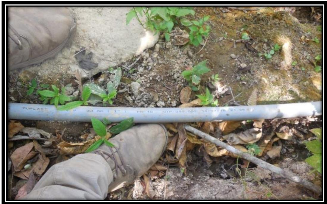
*Fotografía 10:* Línea de conducción “Las Nanas” Tramo 2 expuesto LC3.
