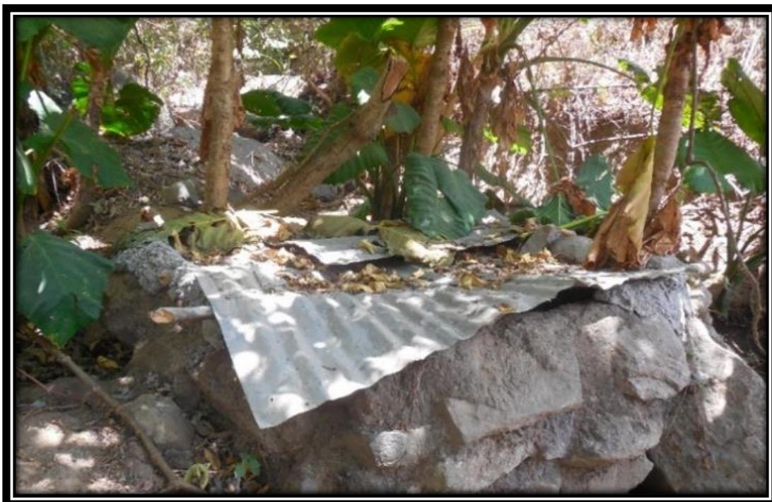
**Fotografía 04: Captación 01 “Las Nanas” Lecho filtrante protegida por calamina, construida si dirección técnica afectada por el Fenómeno del niño.**
