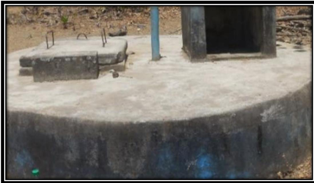
*Fotografía 16: Reservorio existente enterrado y deteriorado uno de los lados.*
