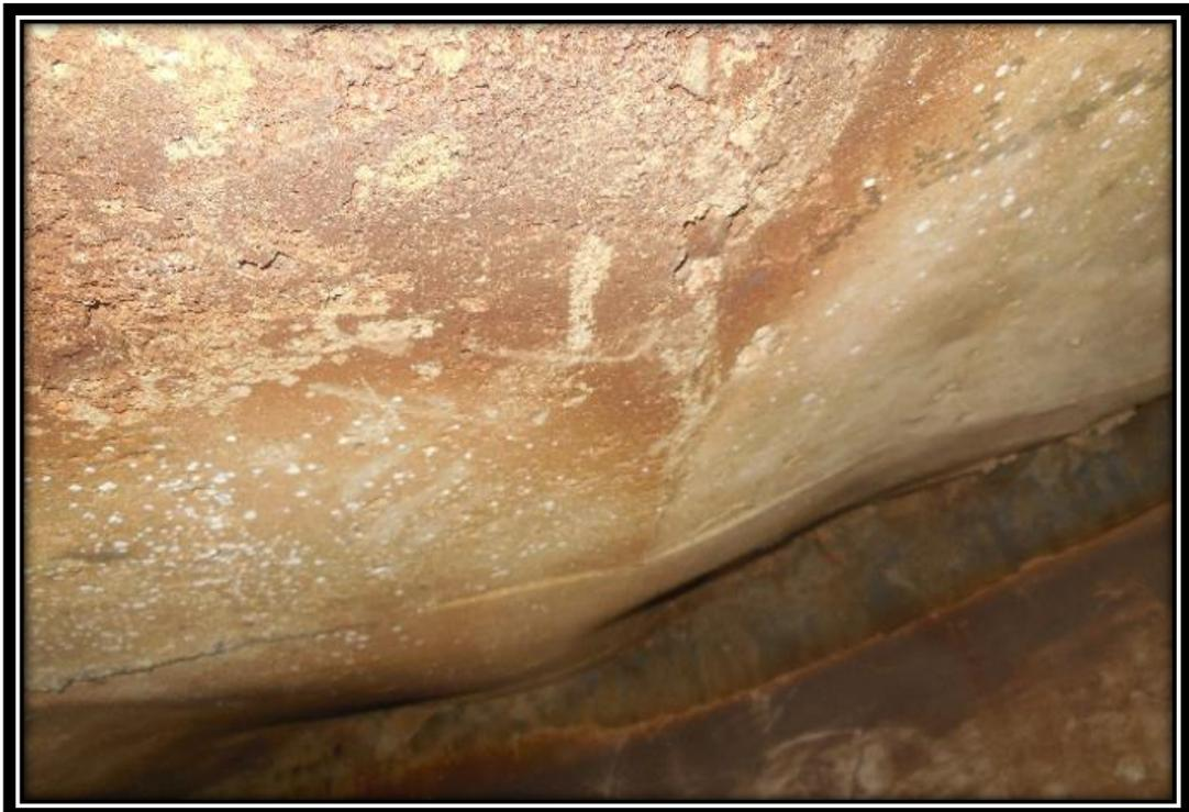
*Fotografía 20:* **Reservorio existente techo flexionado.**
