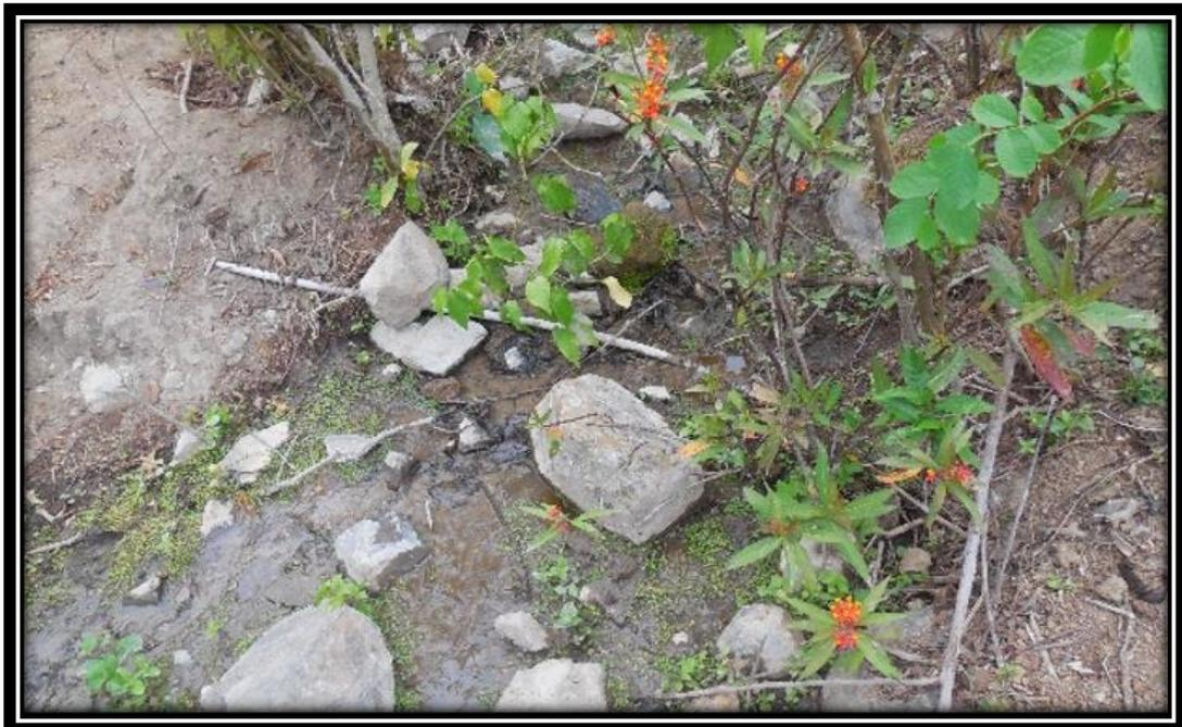
*Fotografía 12:* Línea de conducción “La Hornilla” Tubería de PVC expuesta de Ø1/2” de color blanco en terreno estable.
