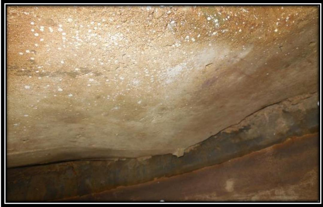
*Fotografía 19:* **Reservorio existente Techo de reservorio con fisuras.**
