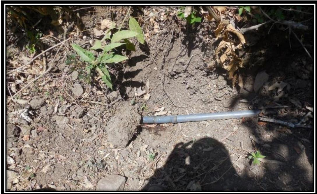
*Fotografía 11:* Línea de conducción “Las Nanas” Tramo 3 expuesto: LC3 fuga.
