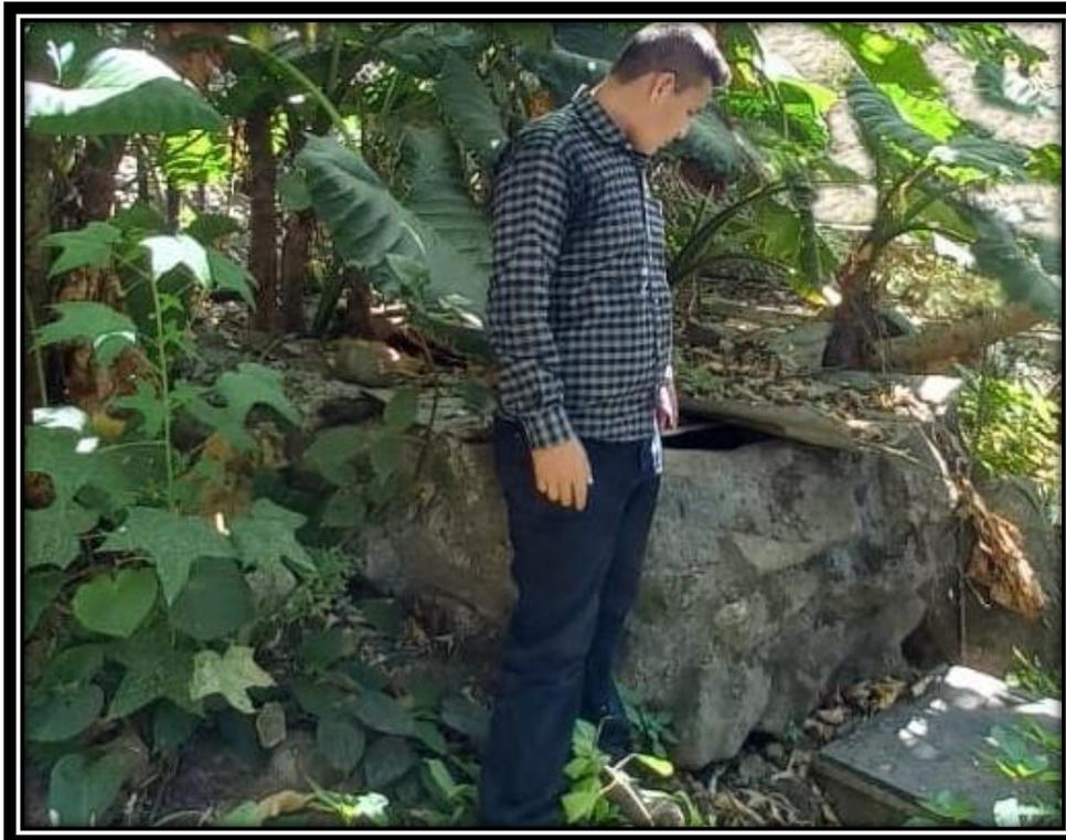
**Fotografía 03: Captación 01 “Las Nanas” Cerca no segura de la captación La Nana, el lecho es la mampostería de piedra y la cámara húmeda es de concreto sin tapa sanitaria.**
