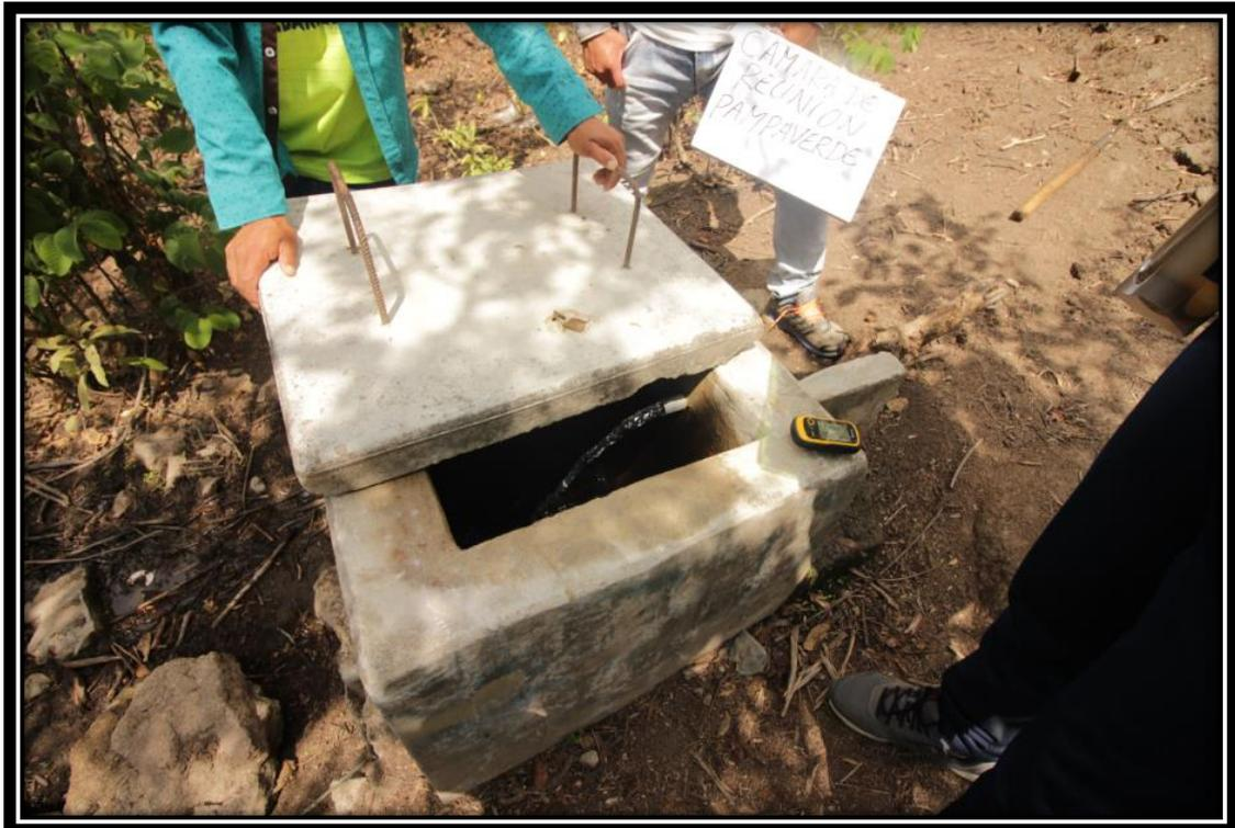
*Fotografía 21:* **Cámara de reuniones existente enterrada y deteriorada en mal estado.**
