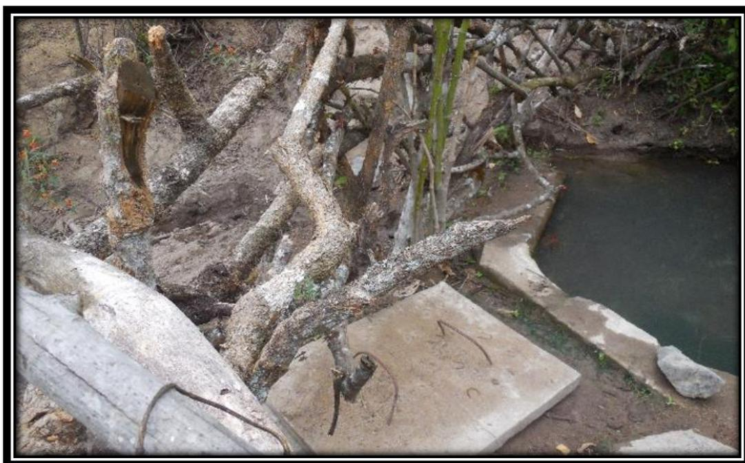
*Fotografía 06: Captación 02 “La Hornilla”. sin lecho filtrante y con tapa no sanitaria, de concreto deteriorado.*
