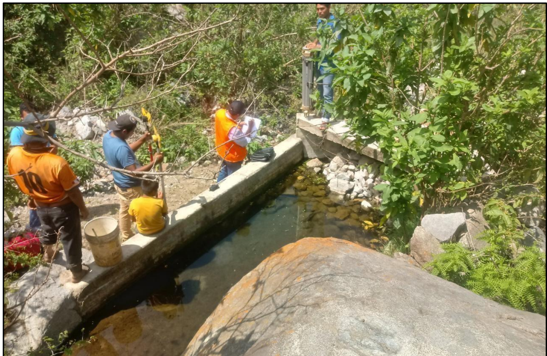
Imagen 2: Toma de puntos topográfico en la captación Ichoca
