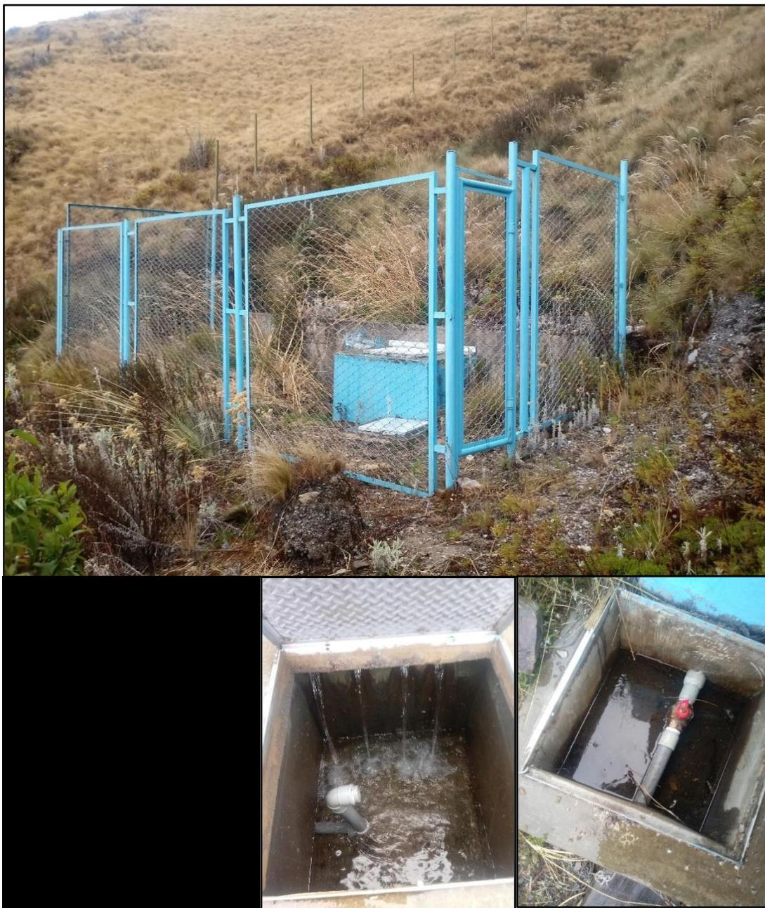
Fotografía 1: se observa la captación, y sus respectivos componentes: zona de afloramiento, cámara húmeda y cámara seca, esta estructura está en la parte alta de las punas de Urcón
