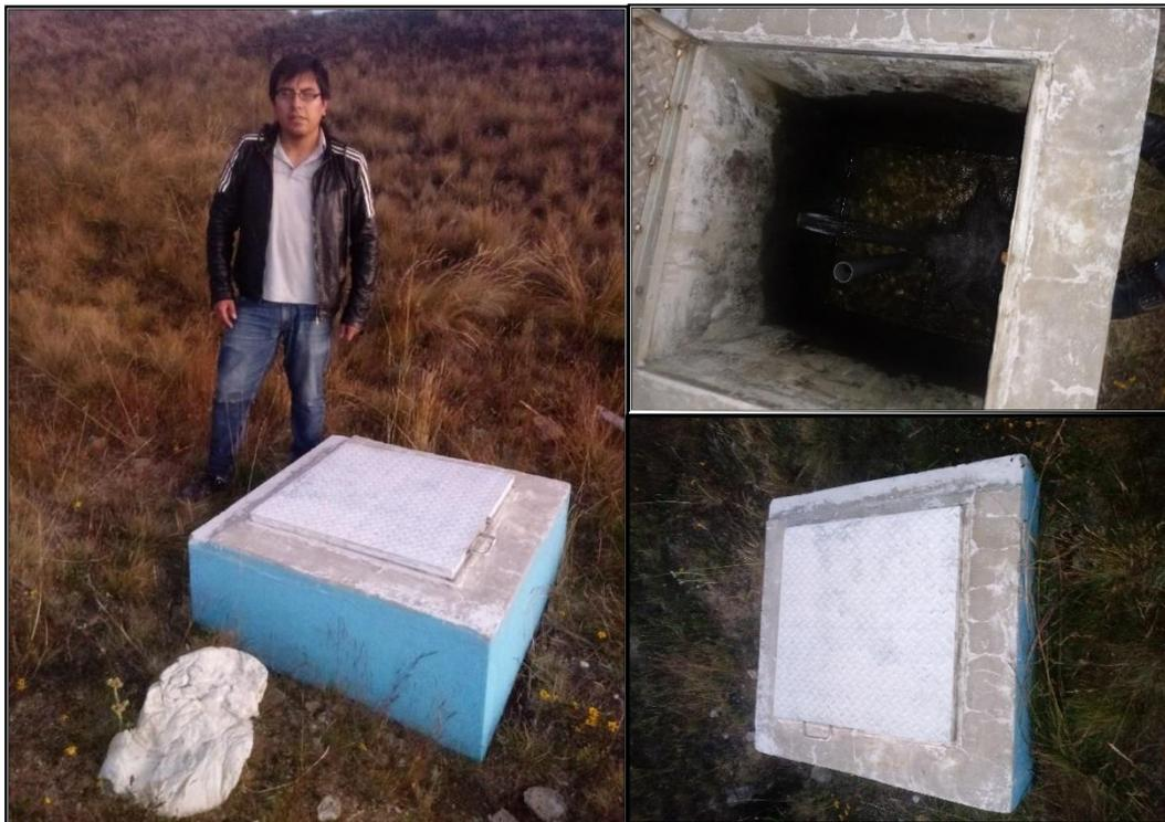
Foto 3: se observa la cámara rompe presión, en la trayectoria de la línea de conducción, se puede observar siete unidades de cámaras rompe presión tipo 6.
