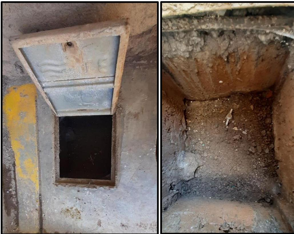
Fotografía 5: se observa caja de paso que esta implementada con tapa metálica, pero con deficiencia en las instalaciones domiciliarias.
