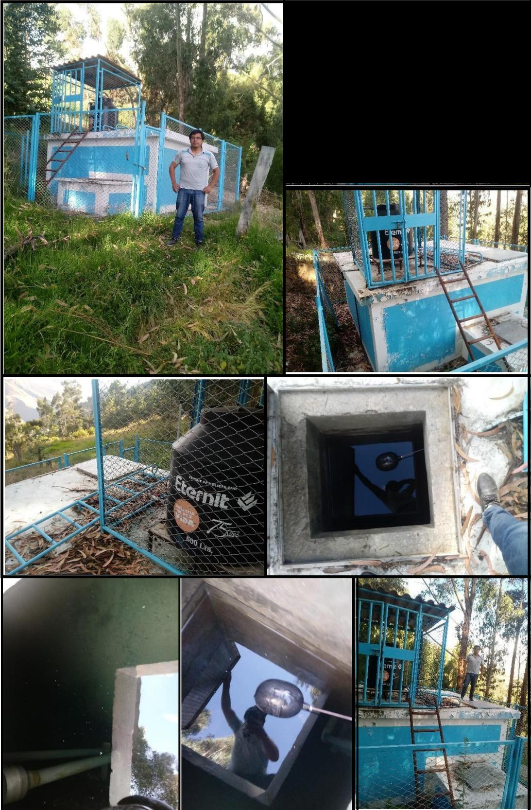
Fotografía 4: Se puede observar la estructura de almacenamiento, con sus respectivas partes, el reservorio 20m<sup>3</sup>, caseta de válvulas, caseta de cloración, protección del
