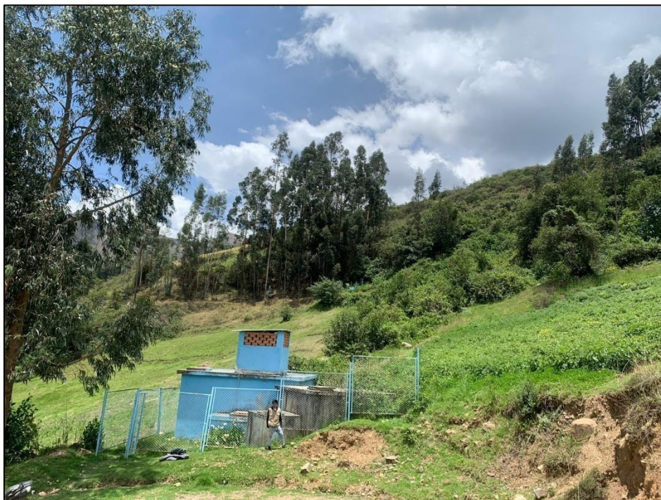
Imagen 4: Se puede observar el reservorio que se encuentra a ubicada a 2946.9 m.s.n.m
