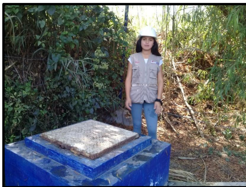
Imagen N ª 04: Cámara de captación del caserío de Larea Baja, distrito de Moro, provincia de Santa, región Áncash.
