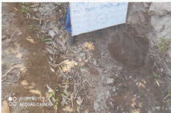
VISTA DE LA EXCAVACION DE LA CALICATA C-03
