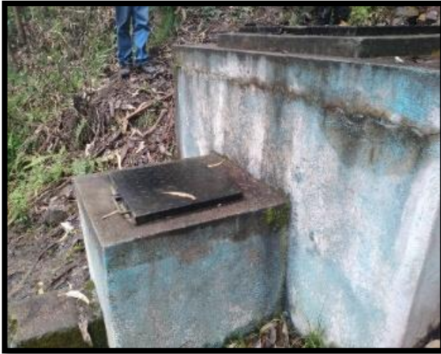
Fotografía 1: Captación, La fuente es subterránea y el tipo de captación es manantial de ladera
