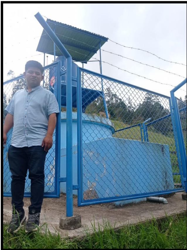
Fotografía 2: Reservorio, donde es almacenada y clorada para su eventual consumo de la población.
