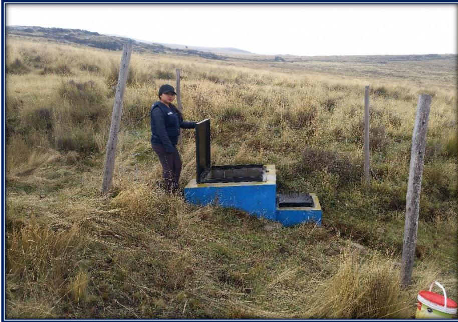
**Imagen 26:** Realizando la evaluación de la captación existente, donde se aprecia que falta el cerco perimétrico de protección.
