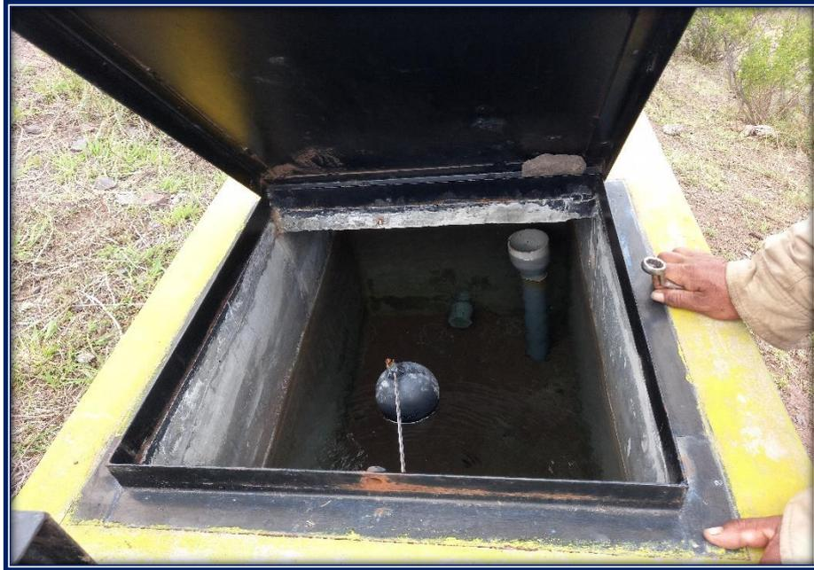
**Imagen 28:** Realizando la evaluación de la Cámara de rompe presión tipo 7 existente.
