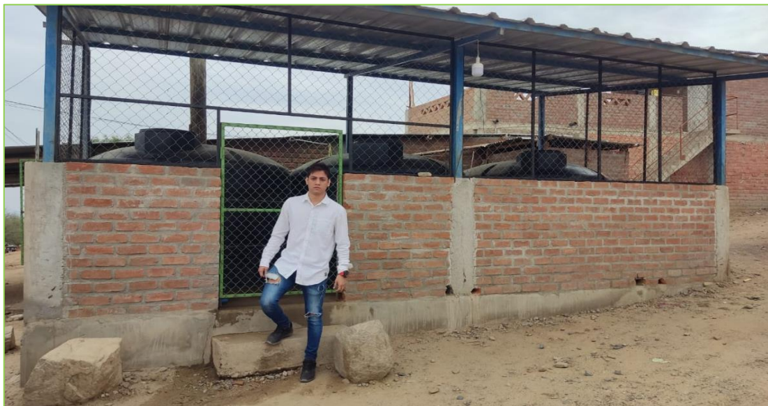
Fotografía 06: Pilón o tanque #3 de almacenamiento existentes para abastecer a población momentáneamente por la falta de un sistema de abastecimiento de agua potable.
