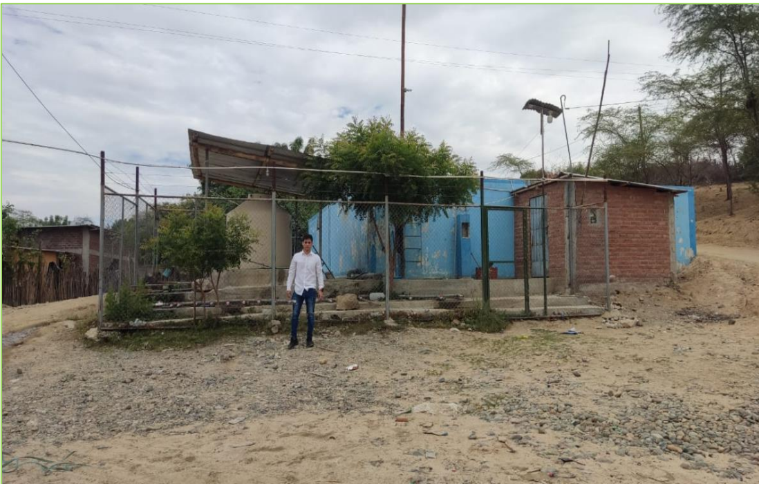
Fotografía 06: Pilón o tanque #1 de almacenamiento existentes para abastecer a población momentáneamente por la falta de un sistema de abastecimiento de agua potable.
