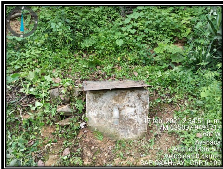
**Fotografía 04:** Estas imágenes muestran el estado de la estructura mostrando el declive que tiene debido a erosión de la base por las lluvias
