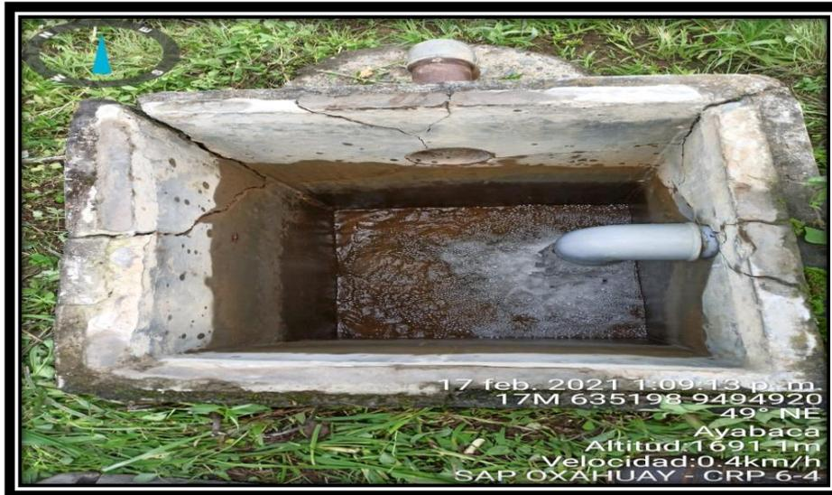
**Fotografía 03:** La CRP se muestra en el colapso total de la estructura con grietas por antigüedad y la a afectación por el FEN del niño costero
