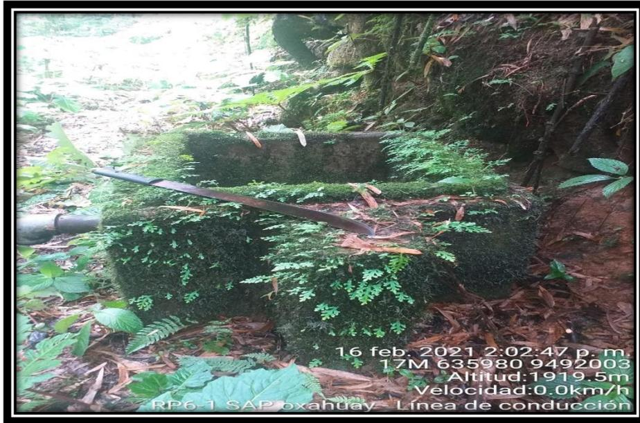
**Fotografía 01:** Aquí se muestra en muy mal estado de la CRP de deterioro 100% el cual no brinda ninguna garantía ni dándole mantenimiento por que la afectación por el FEN del niño costero termino por deteriorada completamente
