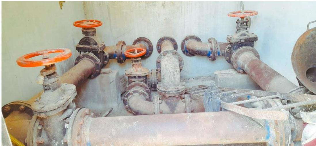
**Imagen 16: Caseta de válvulas en el reservorio apoyado**
