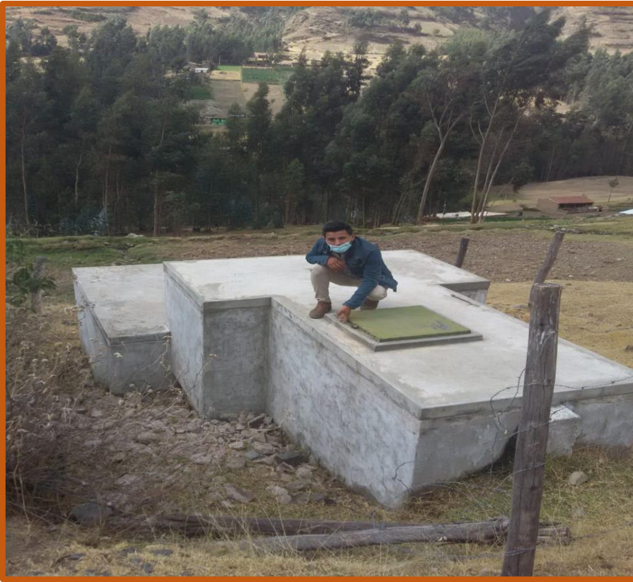
Fotografía 01: captación del sistema de agua
