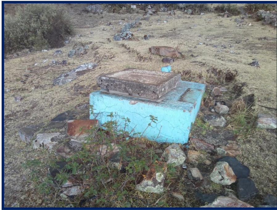
Imagen N° 2. Cámara rompe presión en la línea de conducción.
