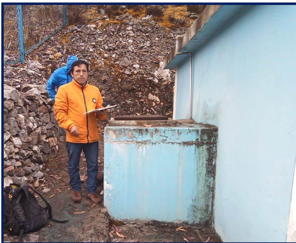
Imagen N° 3. Reservorio del centro poblado de Uchuhayta, en la zona de Hatun Rumi.
