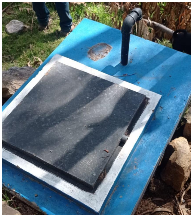
FOTO N° 20: PRIMERA CAMARA ROMPE PRESION TIPO 7 SU ESTADO ACTUAL EN LA QUE SE ENCUENTRA
