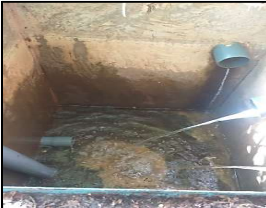
Foto N° 02: Cámara húmeda es de concreto armado, sus dimensiones son 1.20x1.20x1.20m, con tapa sanitaria de metal de dimensiones 0.65x0.65m
