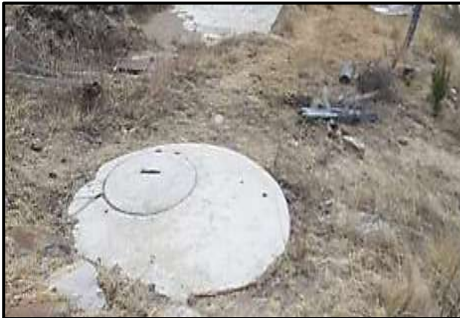
Foto N° 08: Los buzones no han presentado defectos en su funcionamiento debido a que no existen obstrucciones ni colmatación. Obstrucciones a la fecha, no tiene buena pendiente.
