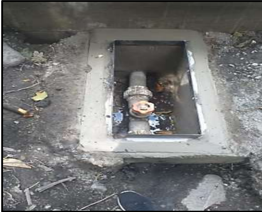
Foto N° 05: La caja de válvulas del reservorio: su tapa es de material metálico de dimensiones 0.75x0.75m
