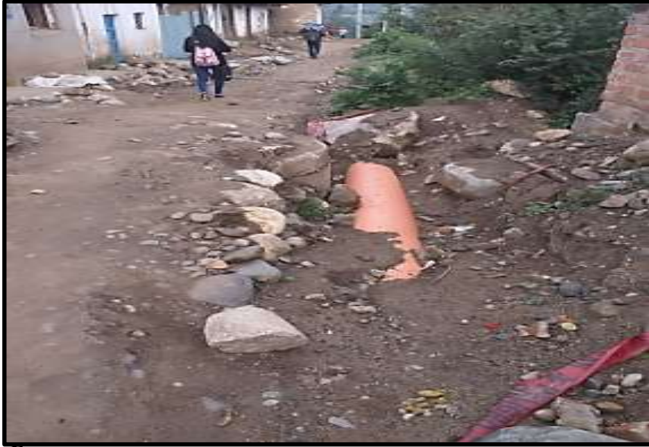
Foto N° 07: Las tuberías de las redes colectoras se encuentran en estado deteriorado, presentado defectos en su funcionamiento debido a que existen
