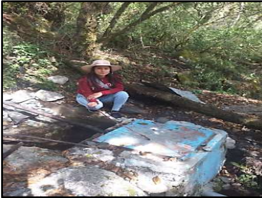
Foto N° 01: captación de manantial ladero, con lecho filtrante y sello de protección sus dimensiones son 1.10x4.20m.
