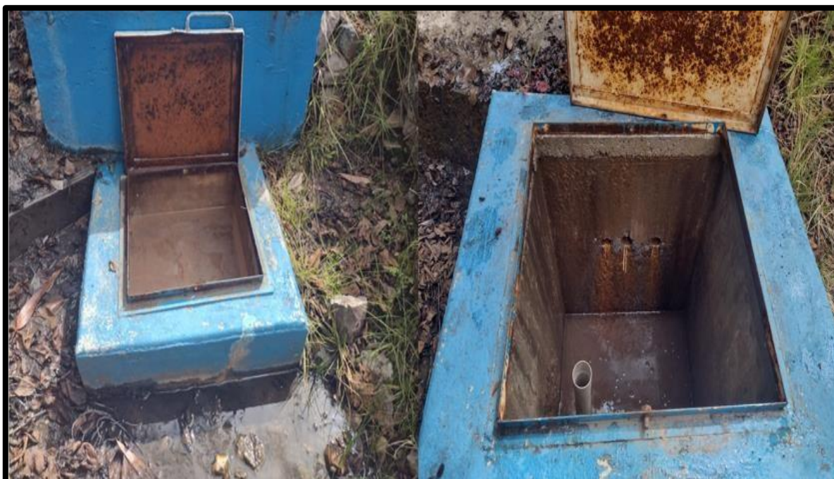
Fotografía N° 04. Evaluación de la captación por el interior
