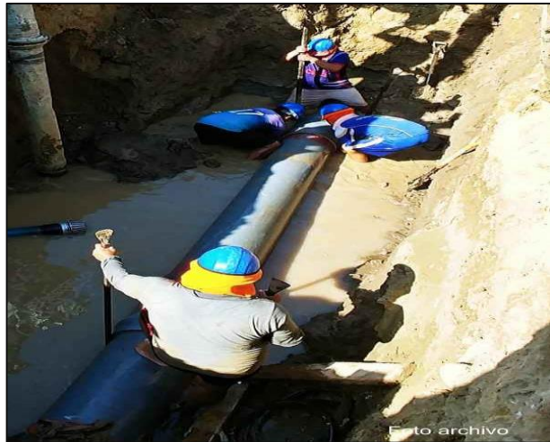
Figura 11: línea de impulsión
