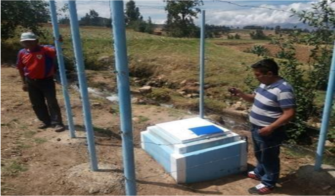
Figura 22: Cámara rompe presión
