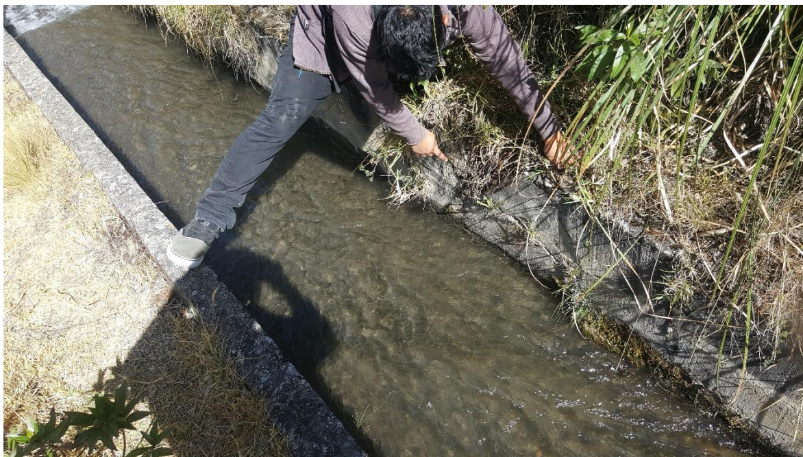
Fotografía 01: Toma de medidas del canal
