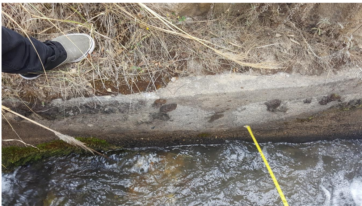
Fotografía 02: Toma de medidas del canal
