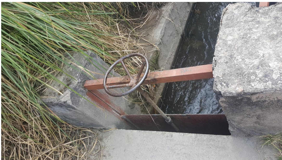
Fotografía 08: Toma de medidas del canal
