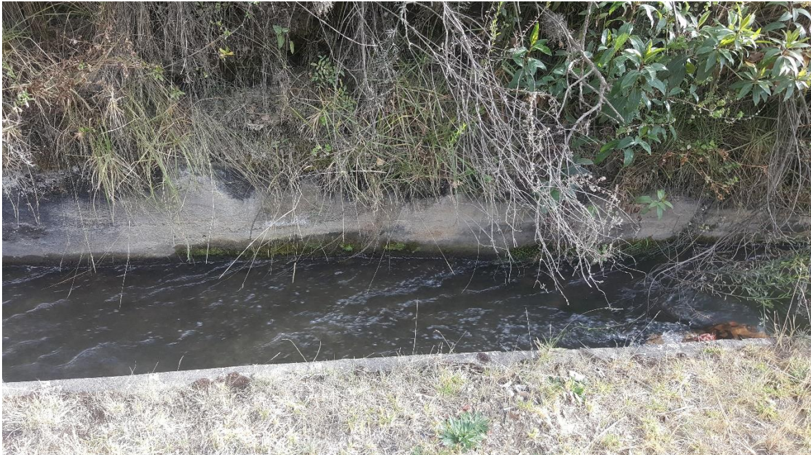
Fotografía 09: Toma de medidas del canal
