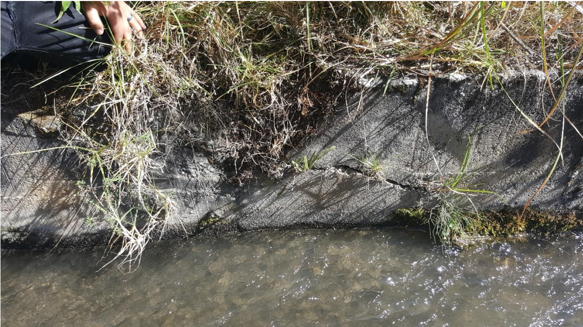
Fotografía 05: Toma de medidas del canal
