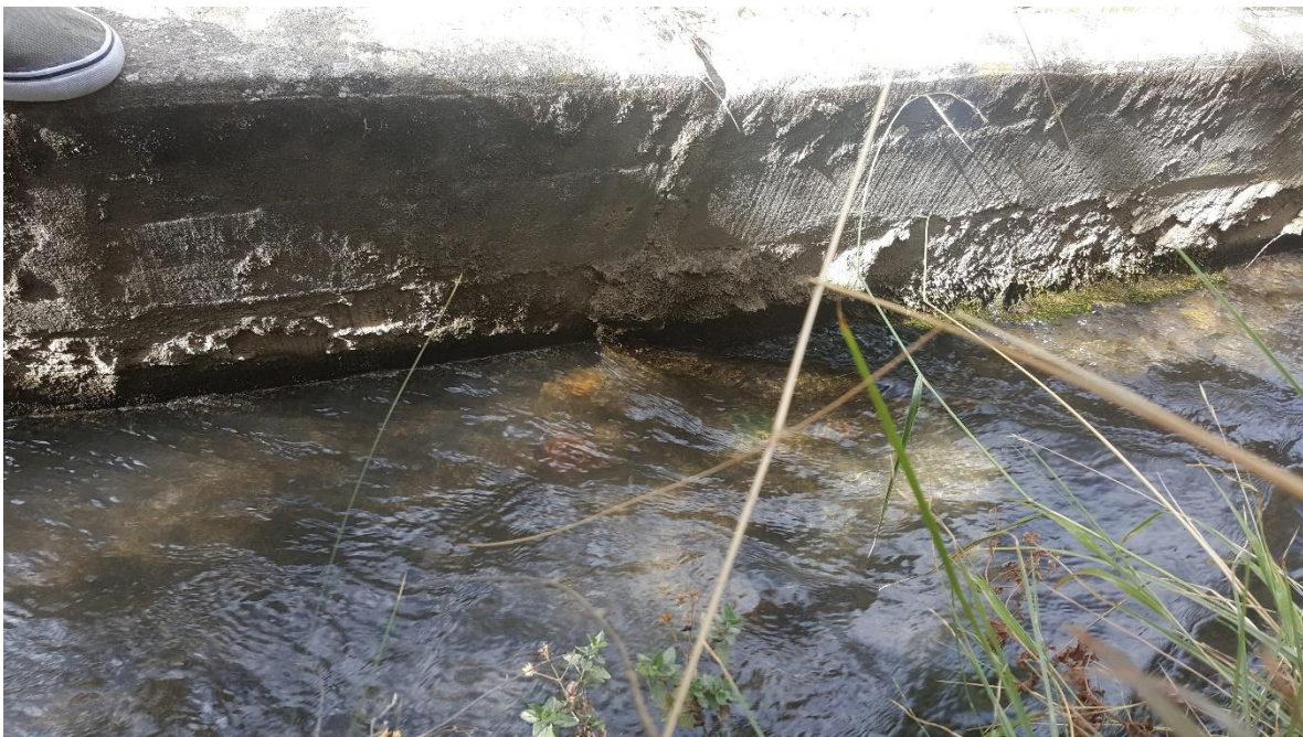
Fotografía 12: Toma de medidas del canal
