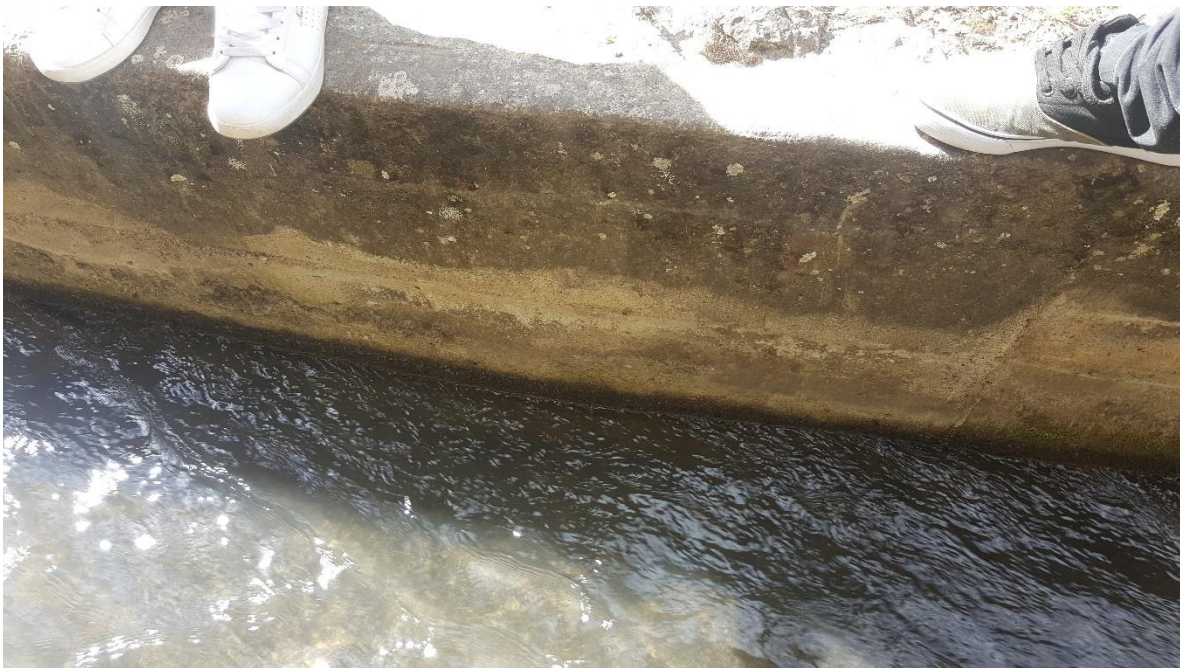
Fotografía 04: Toma de medidas del canal
