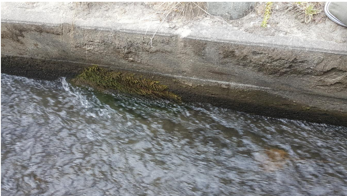
Fotografía 10: Toma de medidas del canal
