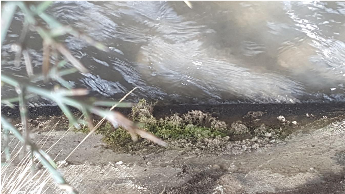
Fotografía 11: Toma de medidas del canal
