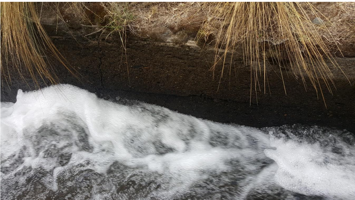
Fotografía 06: Toma de medidas del canal
