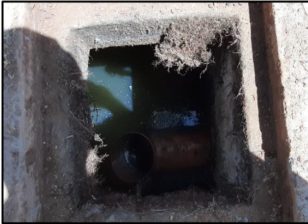
Figura 57: Pozo séptico
