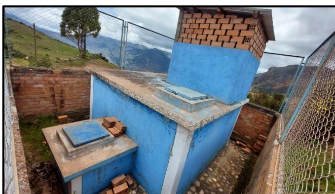
Figura 52: Reservorio, la caseta de cloración y el cerco perimétrico
