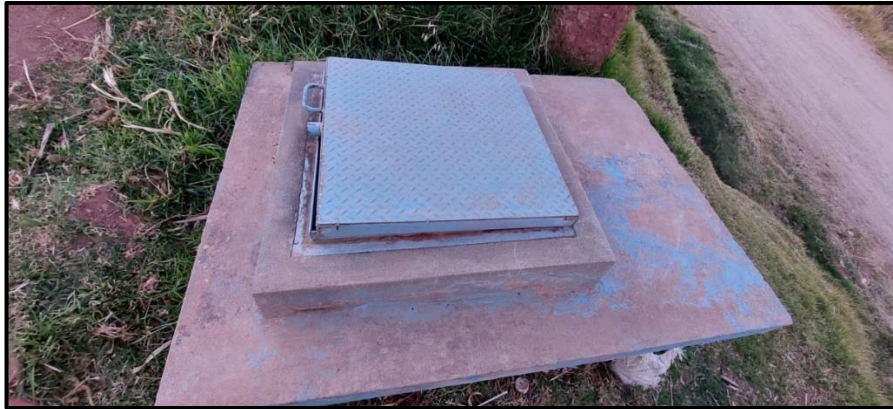
Figura 54: CRP tipo 7, sin el perno de seguridad
