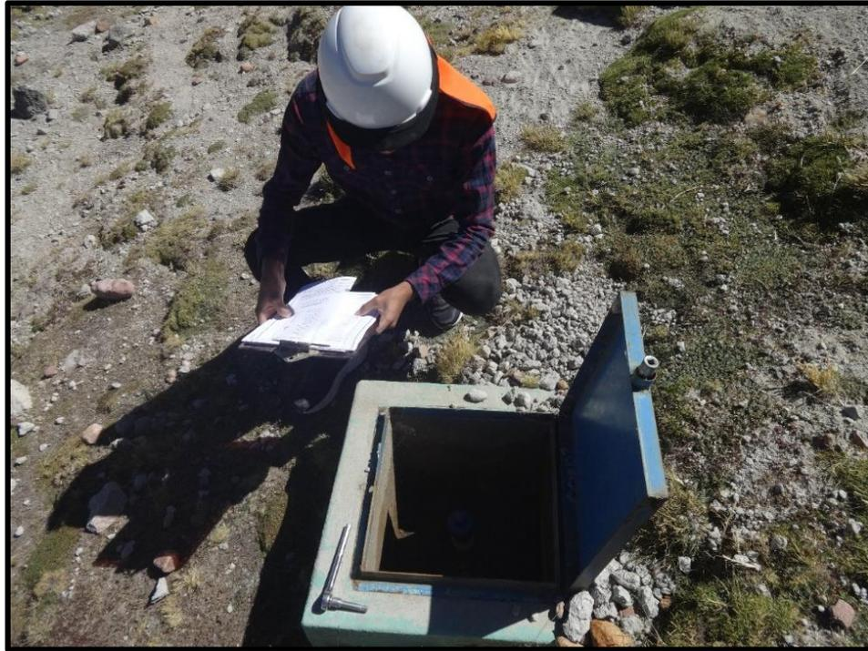
**Figura 36.** Se observa la caja de válvula de aire
