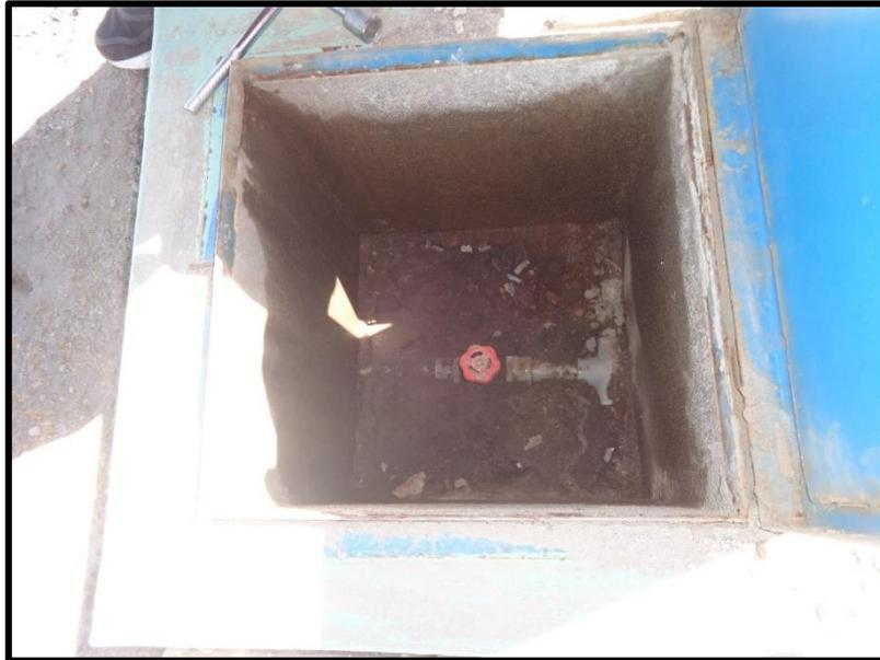
**Figura 38.** Válvula de control para el reservorio
