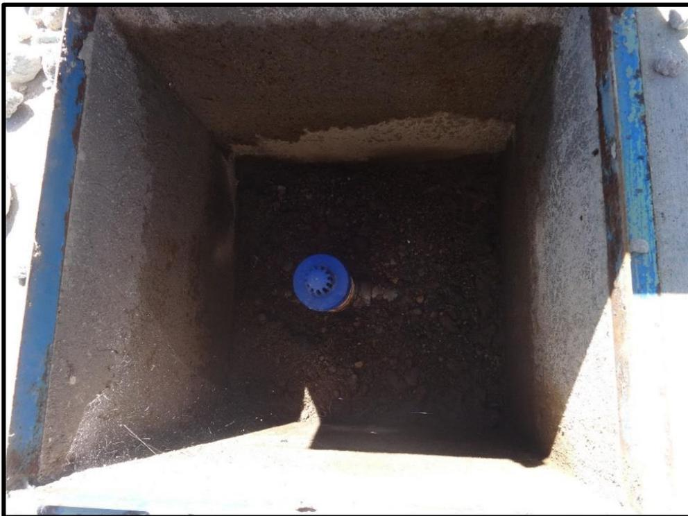
**Figura 35.** Válvula de aire
