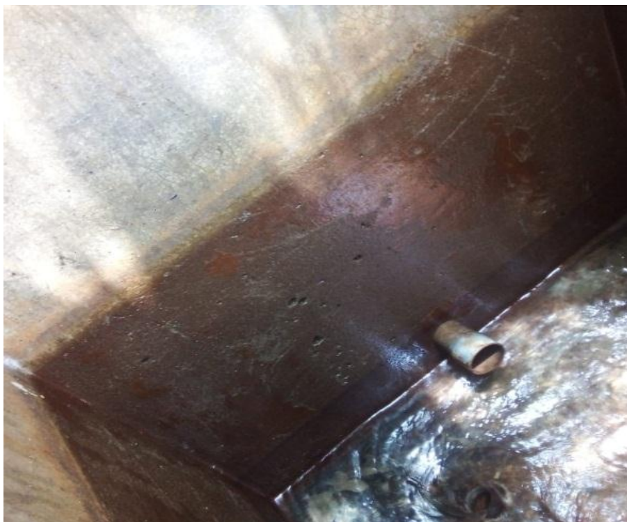
Fotografía 3. No hay canastilla en la Captación
