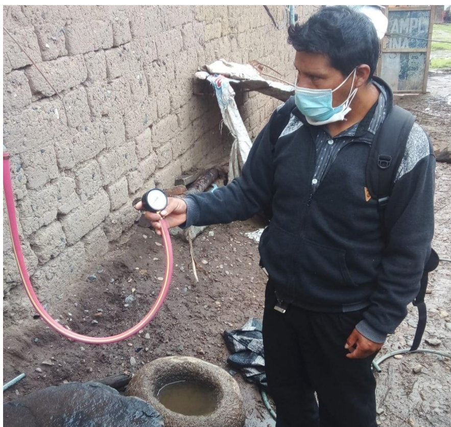
Fotografía 9: Medición de la presión manométrica en las redes de distribución
