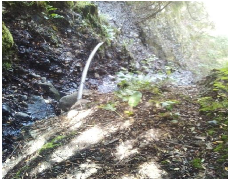
Fotografía 5. Línea de Conducción
