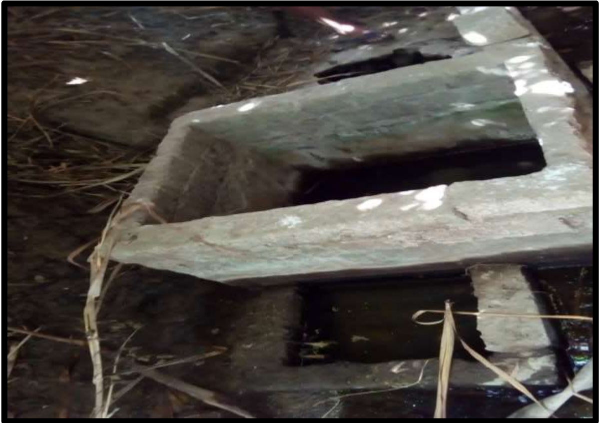
Foto 1: Evaluando la Captación existente
