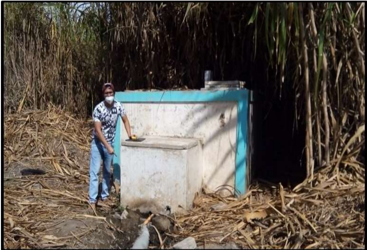
Foto 3: Evaluando el reservorio existente
