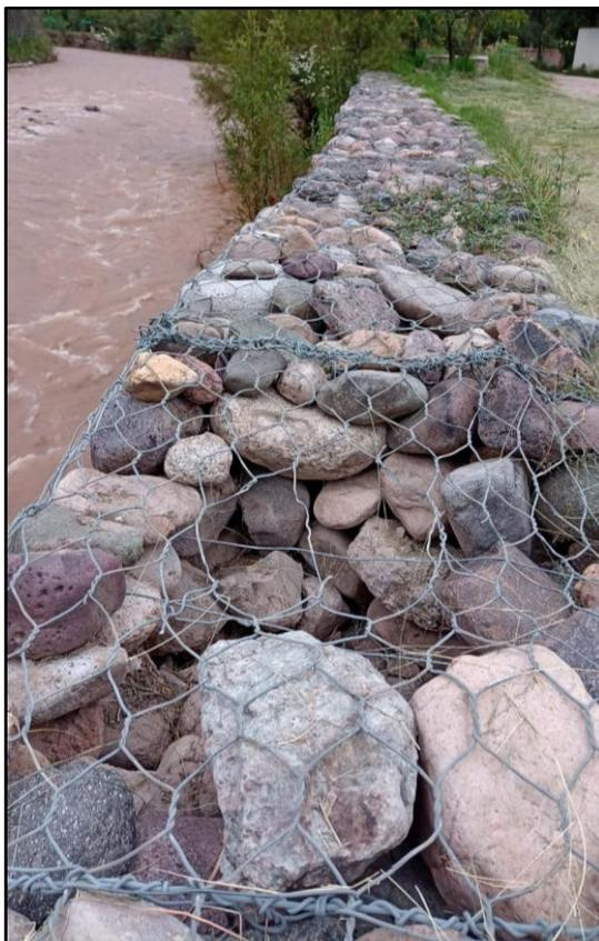
Figura 5: Punto de deficiencia del muro de gaviones.
