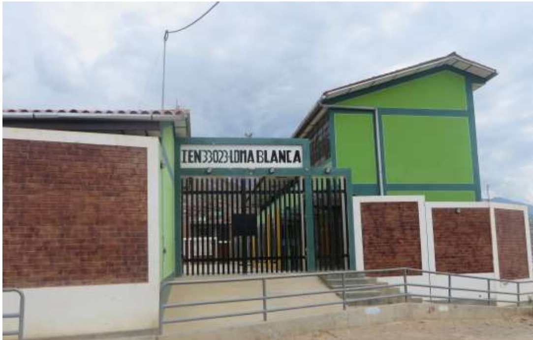
FOTO N° 07. LOCAL DE LA I.E. N° 33023 DE LOMA BLANCA-HUÁNUCO
