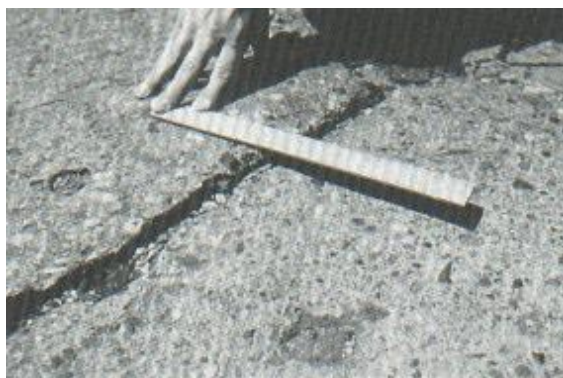
Figura 17. Escala de severidad media.
