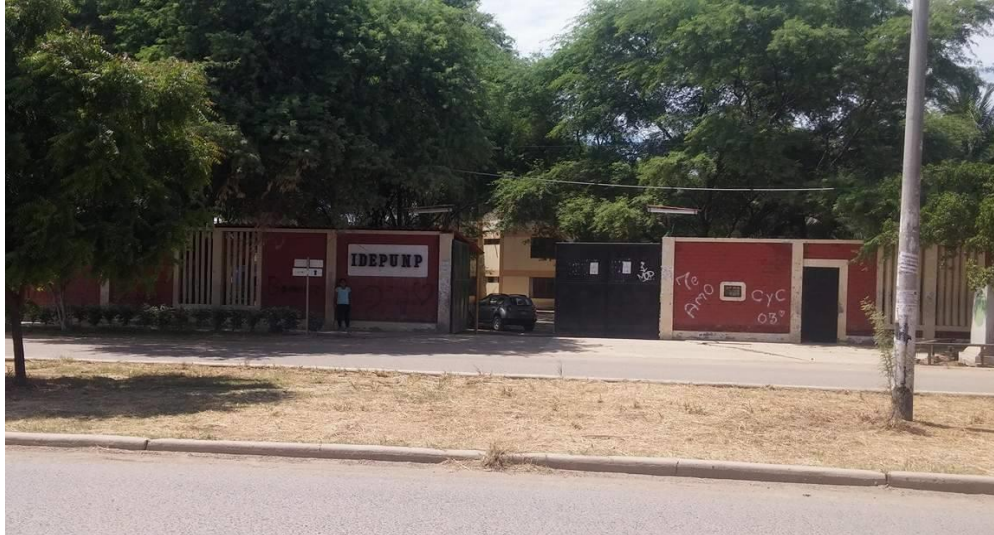
Gráfico 100: Frontis del cerco perimétrico IDEPUNP
