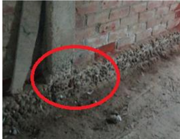
Gráfico 10: Desintegración en sobrecimiento
