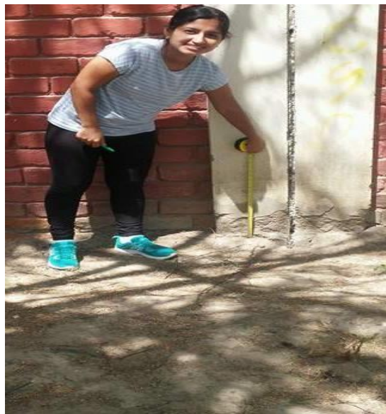
Gráfico 103: Presencia de desintegración en columnas
